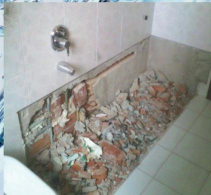
*L'intervento standard effettuato da un qualunque muratore o idraulico per sostituire totalmente il piatto doccia prevede consistenti lavori di muratura, di modifica delle tubature e ripristino delle piastrelle, con un costo medio di circa 3 o 4 volte superiore al nostro sistema di sovrapposizione, quindi poco conveniente in termini di spesa e tempistiche di realizzazione.*
